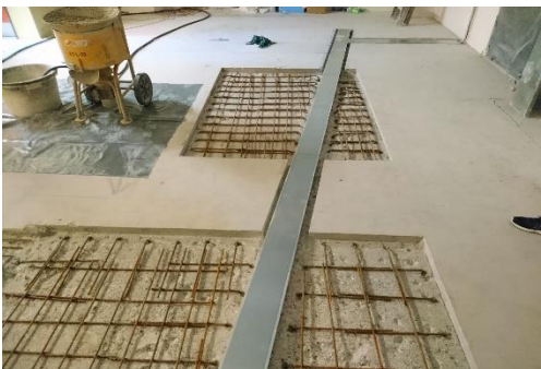
Einbau Bodenkanäle
