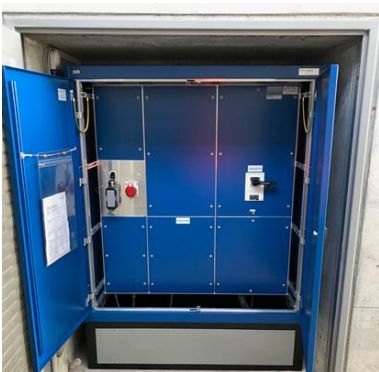
Aussenanschlusskasten mobile NEA
