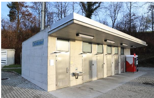
Rastplatz Chilchbühl Öffentliche Toiletten
